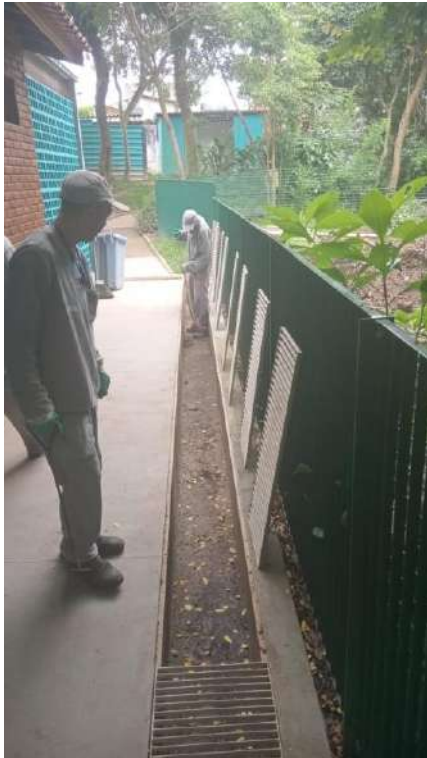
FIGURA 81: LIMPEZA GRELHAS DE CAPTAÇÃO DE ÁGUA PLUVIAL.
