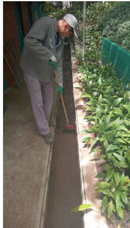
FIGURA 84: LIMPEZA GRELHAS DE CAPTAÇÃO DE ÁGUA PLUVIAL.
