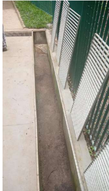
FIGURA 82: LIMPEZA GRELHAS DE CAPTAÇÃO DE ÁGUA PLUVIAL.
