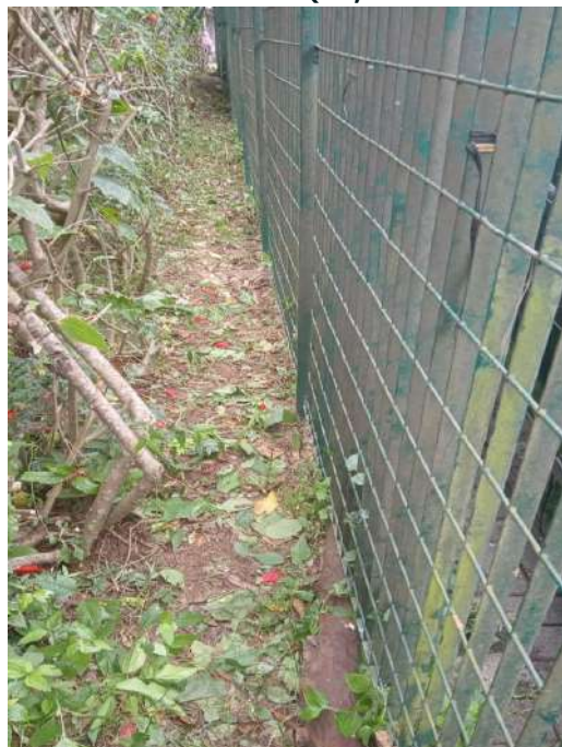
FIGURA 21: LIMPEZA DESPRAGUEJAMENTO DO GRADIL DO PARQUE, ANTES.
