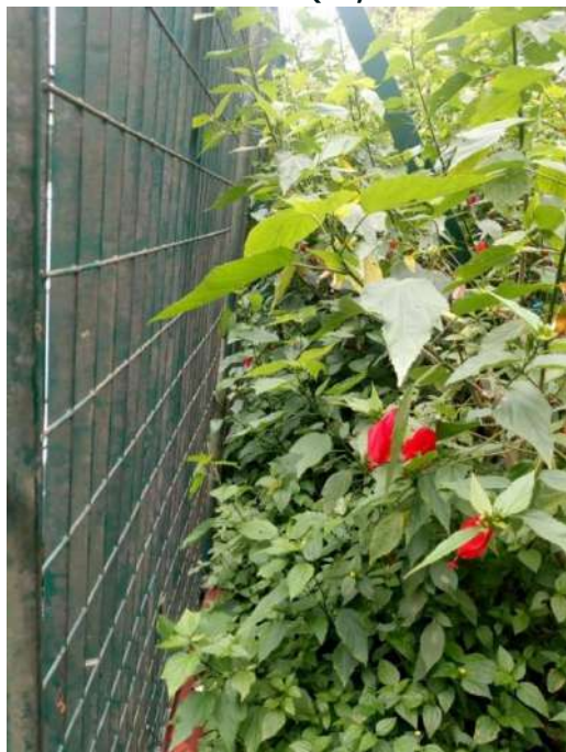
FIGURA 19: LIMPEZA DESPRAGUEJAMENTO DO GRADIL DO PARQUE, ANTES.
