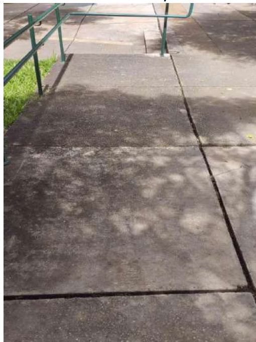
FIGURA 28: LIMPEZA DESPRAGUEJAMENTO DO PISO INTERTRAVADO, DEPOIS.
