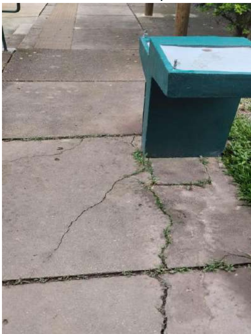
FIGURA 25: LIMPEZA DESPRAGUEJAMENTO DO PISO INTERTRAVADO, ANTES.
