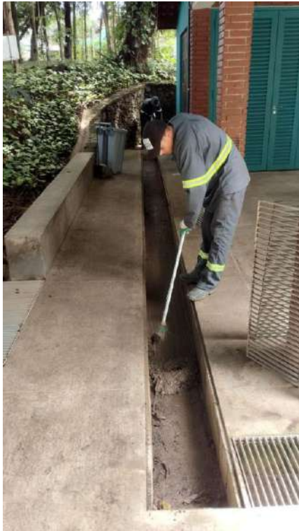
FIGURA 85: LIMPEZA GRELHAS DE CAPTAÇÃO DE ÁGUA PLUVIAL.
