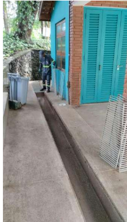
FIGURA 86: LIMPEZA GRELHAS DE CAPTAÇÃO DE ÁGUA PLUVIAL.
