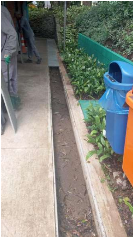
FIGURA 83: LIMPEZA GRELHAS DE CAPTAÇÃO DE ÁGUA PLUVIAL.
