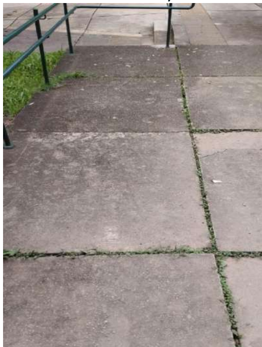
FIGURA 27: : LIMPEZA DESPRAGUEJAMENTO DO PISO INTERTRAVADO, ANTES.
